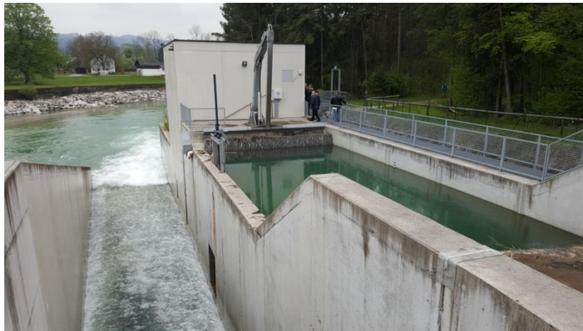
Abbildung 8: Teilansicht des Kraftwerks Kronawettwehr in Unterwöhr (Baujahr: 2012, Engpassleistung: 635 kW)
