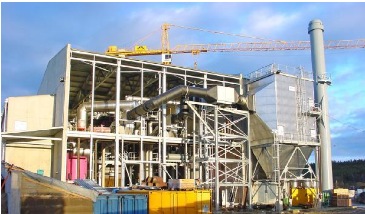
Abbildung 15: Biomasseheizkraftwerk in Altweitra während der Bauphase (Quelle: NAWARO ENERGIE Betrieb GmbH)
