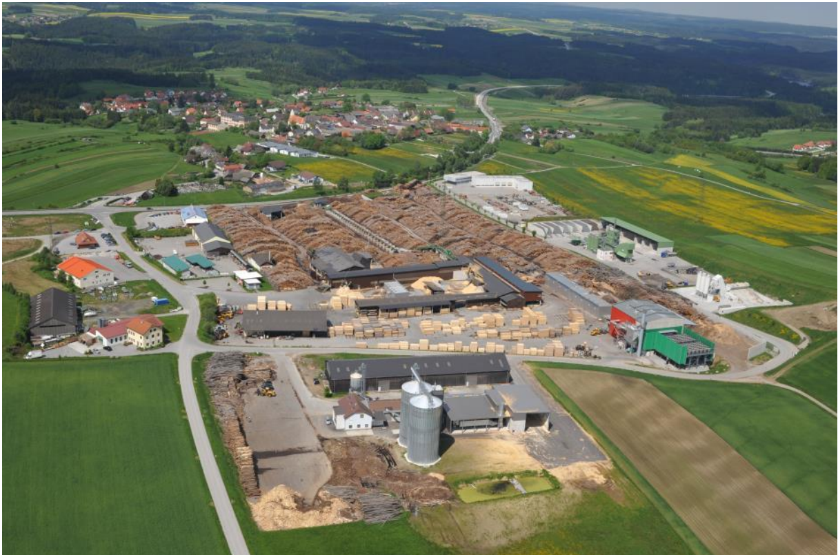
Abbildung 12: Biomasseheizkraftwerk Rastenfeld mit Wärmeabnehmern Säge- und Pelletwerk (Quelle: NAWARO ENERGIE Betrieb GmbH)
