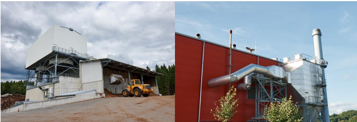
Abbildung 13: Beispielanlagen in Altweitra und Göpfritz an der Wild (Quelle: NAWARO ENERGIE Betrieb GmbH)
